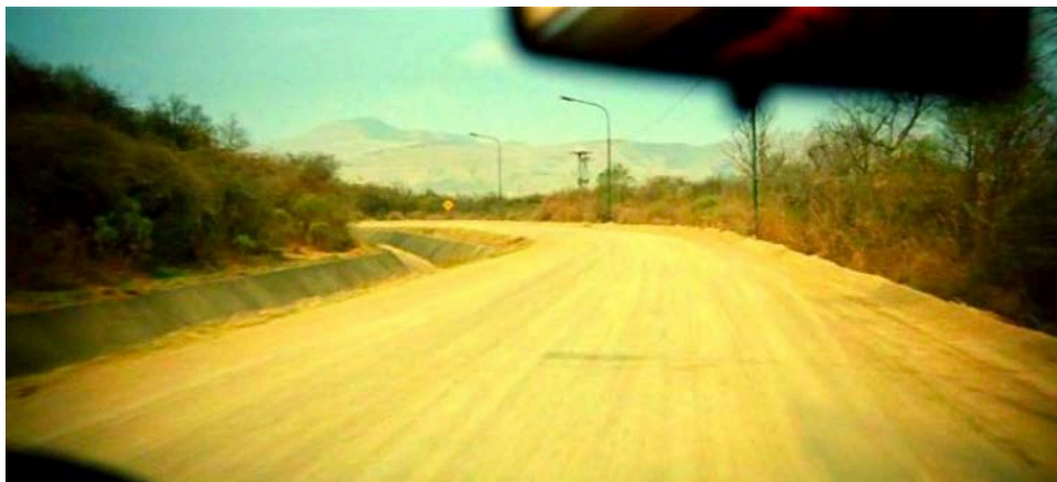
Imagem 1: Estrada de terra com canal na extremidade
